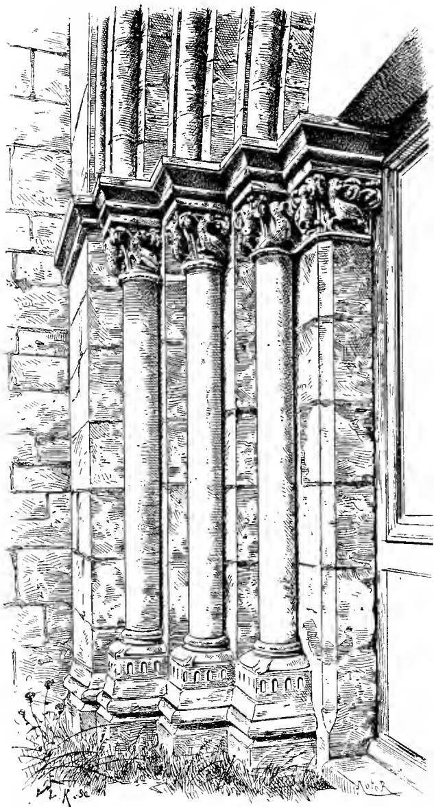
FIG 136. — Jambage de portail de transition à Voulton (Seine-et-Marne).
